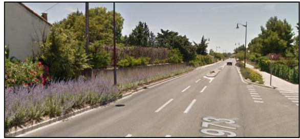
Entrée Nord, Rd973 La Canebière
